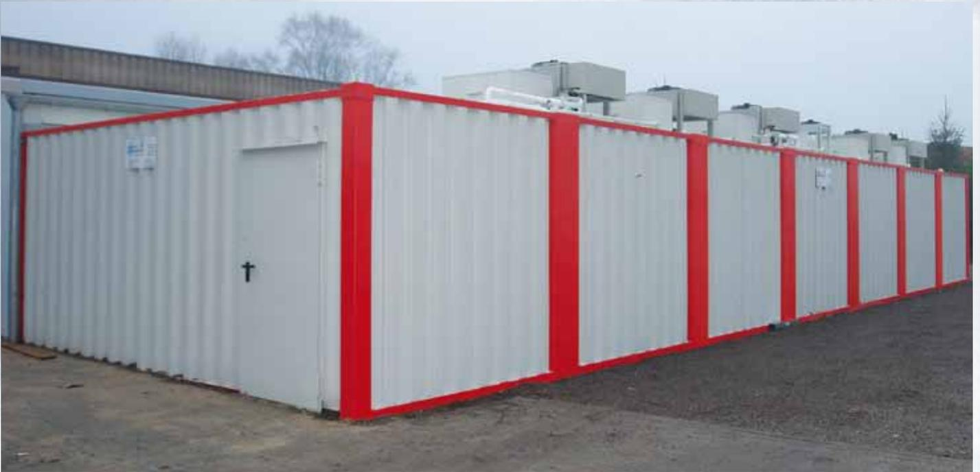
Bei dem angedocktem Schleusensystem werden hier 7 Container in verschiedenen Varianten vor der Auslieferung entsprechend vorbereitet, so dass eine Andockung an die vorhandene Wand problemlos möglich ist.
